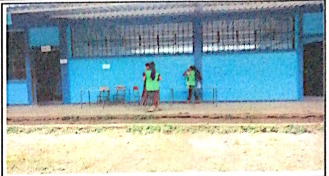
Foto 2: Pintura de muro exterior del edificio.
