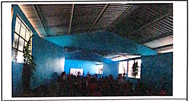
Foto 6: Pintura de muro en el Interior del edificio.
