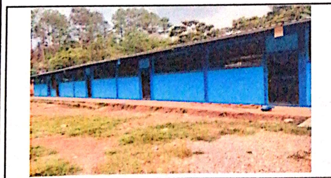
Foto 5: Pintura de muro exterior del edificio.
